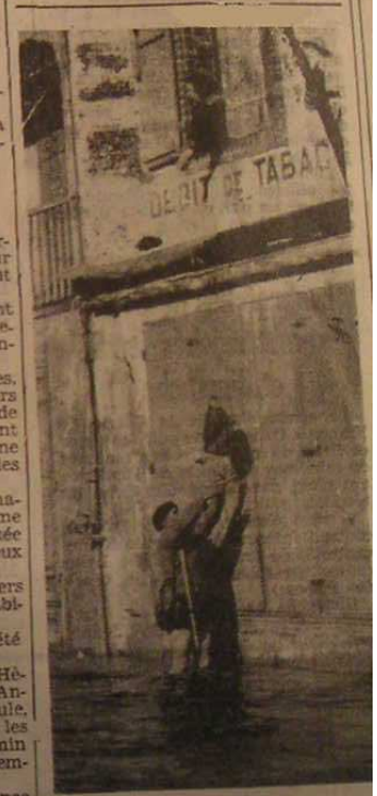
A Maubourguet, des habitants ont dû être ravitaillés par des sapeurs-pompiers qui ne craignent pas les bains d'eau boueuse (Cliché « Nouvelle République » (Photo Alpy, Tarbes))
