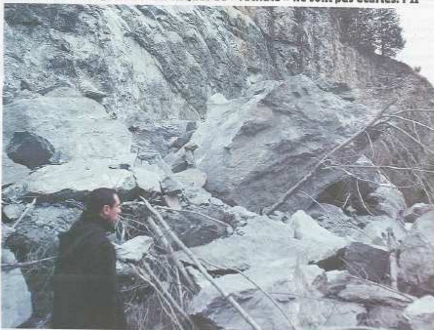
Des blocs de « géant » ont déboulé jusqu'au pied de la falaise des anciennes carrières du pic du Jer. Heureusement, sans victime, ni dégâts matériels. Le siège d'EDF a été épargné grâce à une butte aménagée à cet effet. Photo Laurent Dard.
